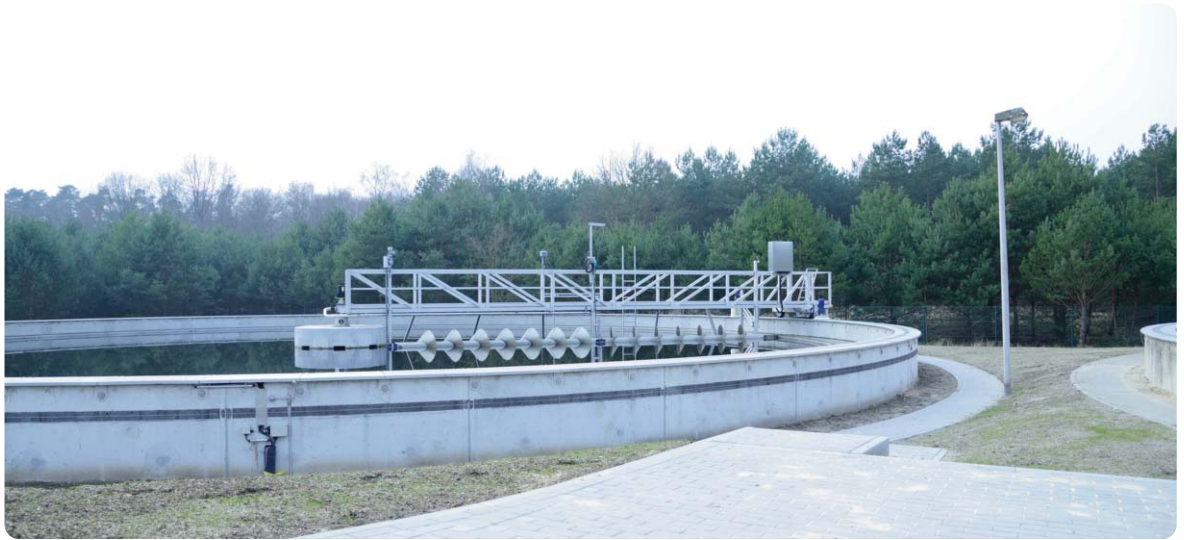
Bild 1: Eines der neuen Nachklärbecken in Fürstenwalde.
