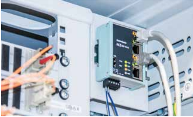
03 Bei Rudolf sitzt der REX 100 zwischen dem Verwaltungs- und dem Produktionsnetzwerk
