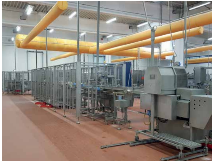
Pro Tag werden am Standort Wilhelmshaven auf Hightech-Linien 1,3 Millionen Fischmahlzeiten hergestellt
